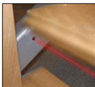
Infrarøde sensorer forhindrer klemning mellem trin.
